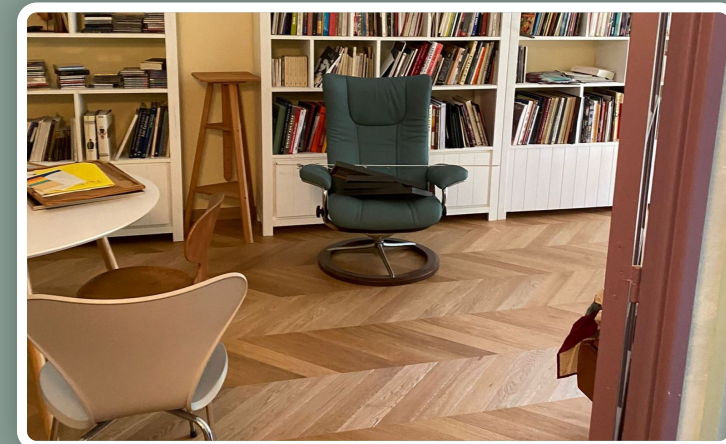
Parquet Pointe de Hongrie moderne en version massif fini usine, en pose collée sur dalle sèche.
