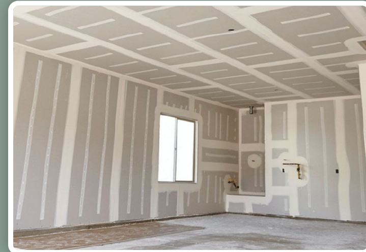
La jonction des plaques de doublage joue un rôle primordial dans l'efficacité de l'isolation.
