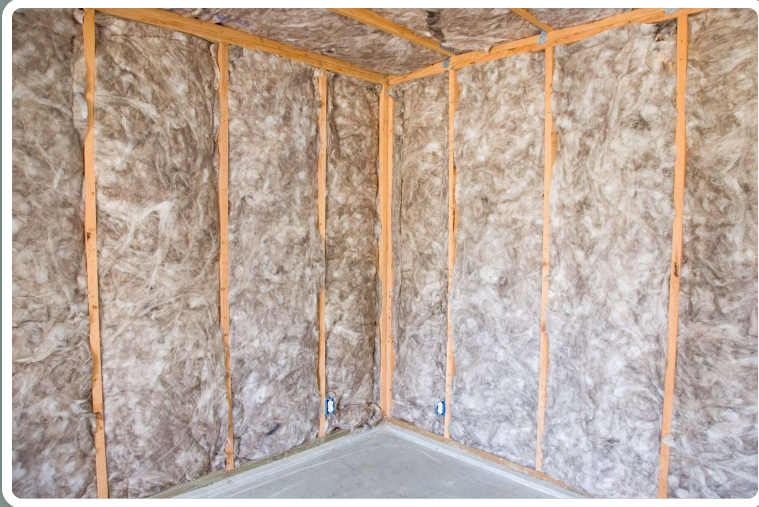
Isolation via ouate de cellulose en panneaux, idéale pour une ossature en bois.
